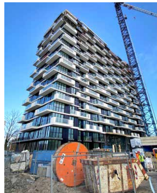
Op de bouwplaats zelf is niet veel ruimte voor de plaatsing van steigers.
