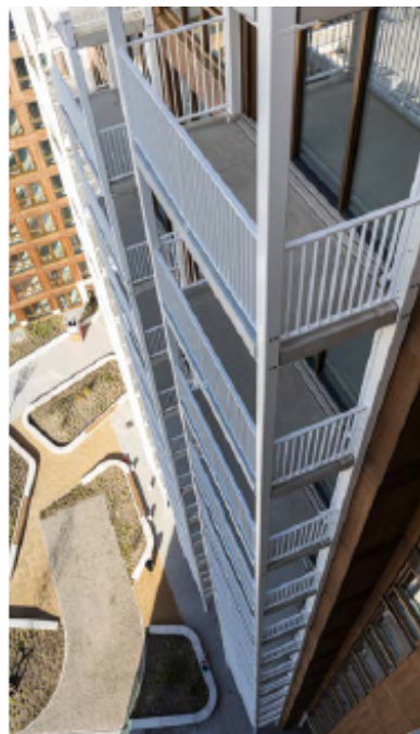
De basis van het gebouw bestaat uit twee betonnen kernen met liften en trappenhuisen, de rest is opgebouwd in houtskeletbouw.
