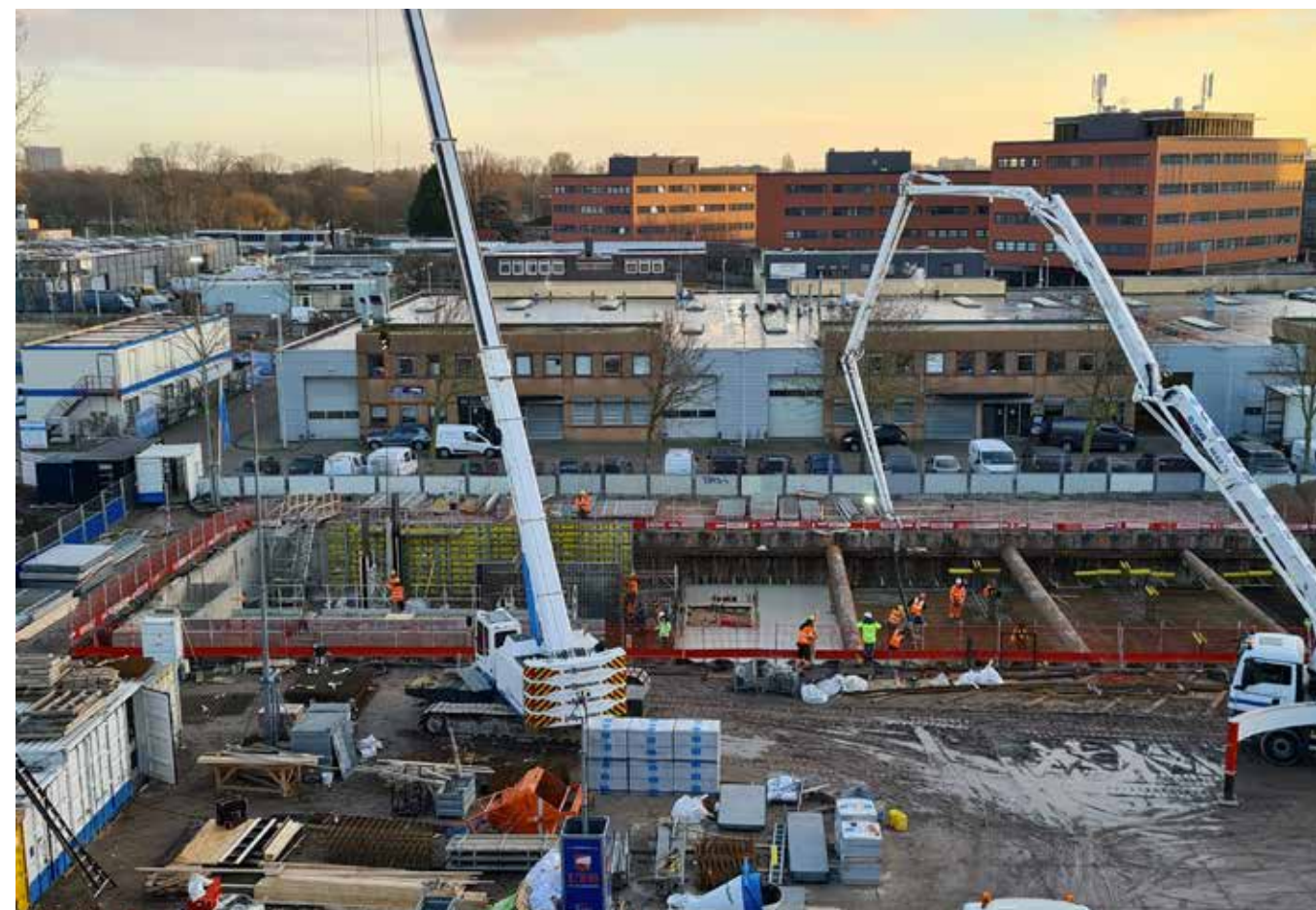
Realisatie van de keldervloer.
