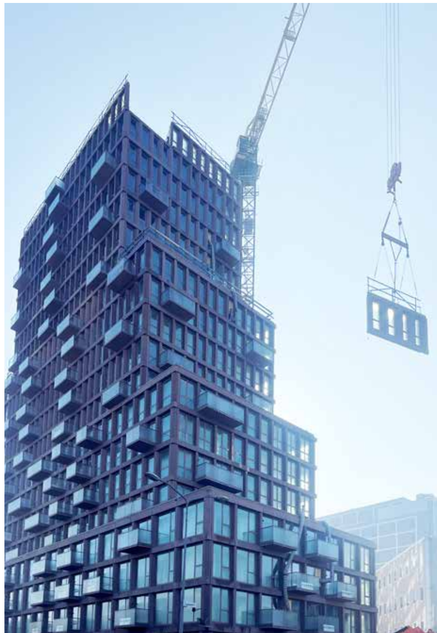
Inhijsen van het laatste gevelement.
