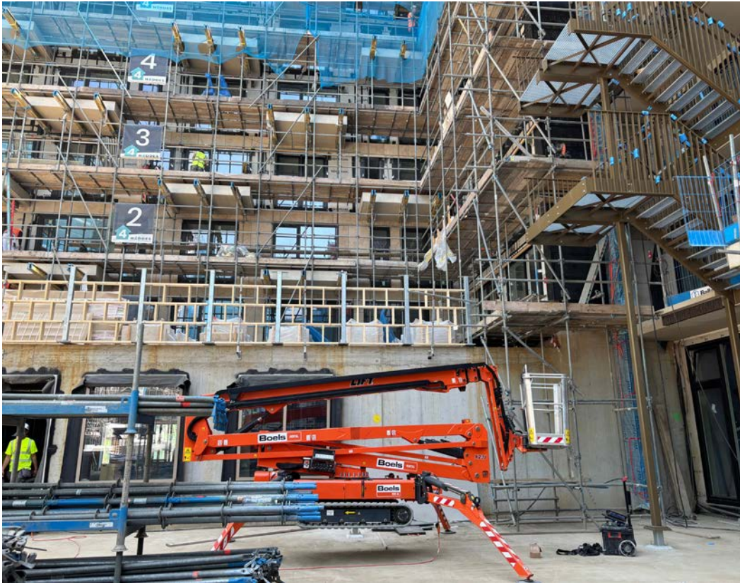
De bouw van Knightsbridge vroeg om technische vernuftigheid.
