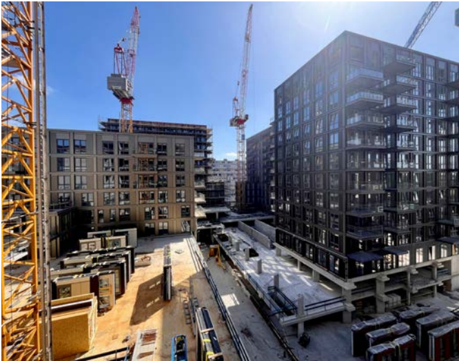
Op de plek van het voormalige stadsdeelkantoor bouwt Heddes Bouw & Ontwikkeling in opdracht van MRP aan een compleet nieuw stuk duurzame en groene stad.
